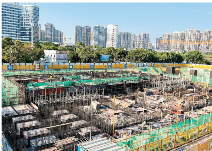
五缘湾调蓄池主体结构接近完工,工人们正紧锣密鼓进行施工。
