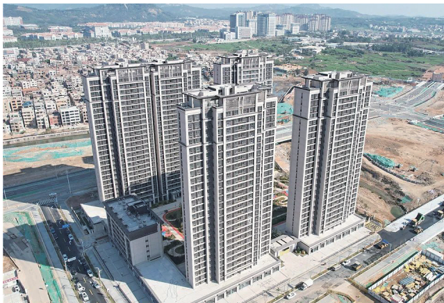
东园保障性住房一期完成预验收。
