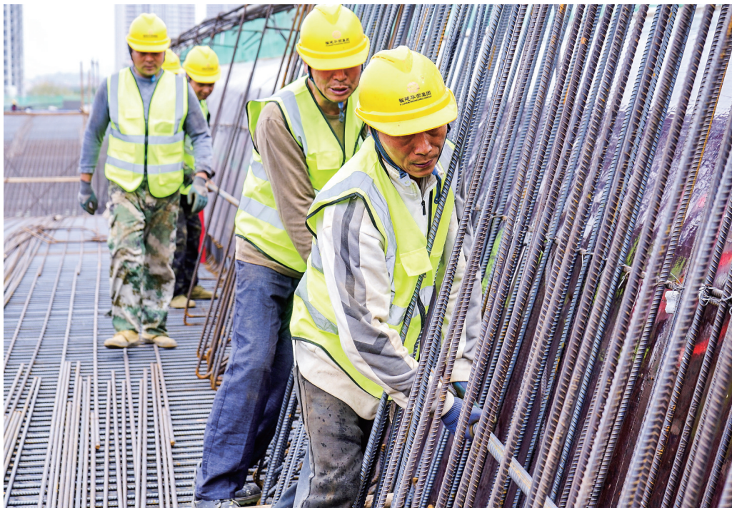
在汀溪西路(凤岭二路—同翔大道段)工程现场,作业人员正在绑扎钢筋。
