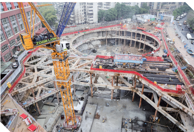
厦门市中医院康复楼正在建设。记者 陈理杰 摄
