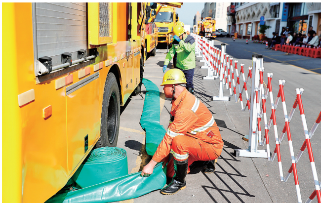
分体式排水车进行排水作业。记者 陈理杰 摄
