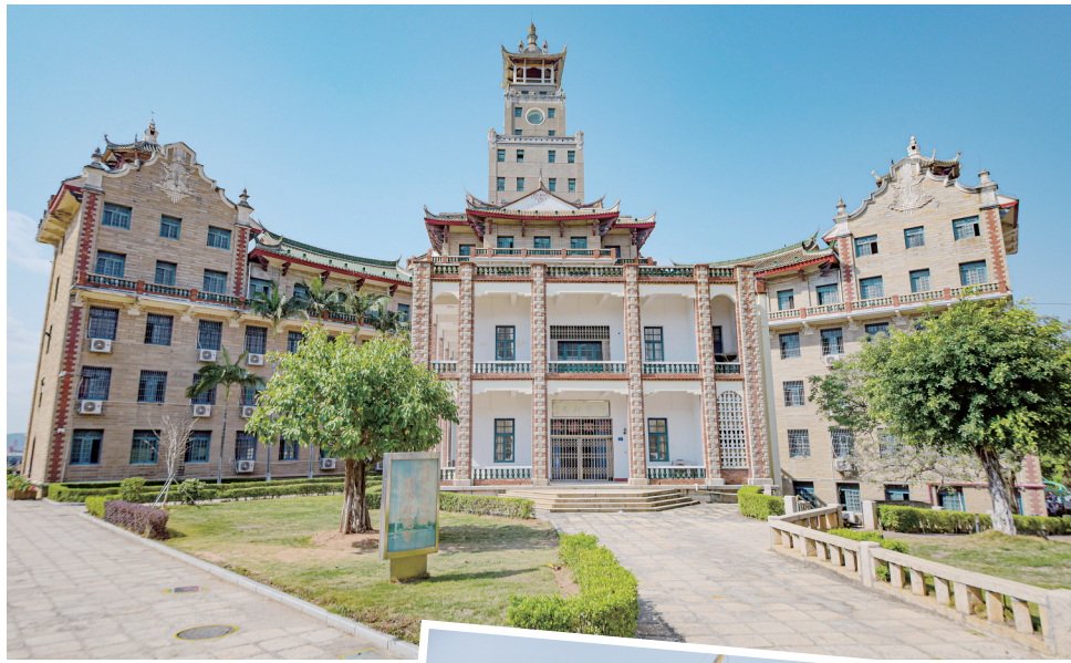
南薰楼远看挺拔雄伟,近观精湛美观。(资料图)通讯员林志杰摄
