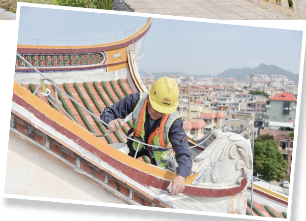
南薰楼修缮正在进行。通讯员林志杰摄
