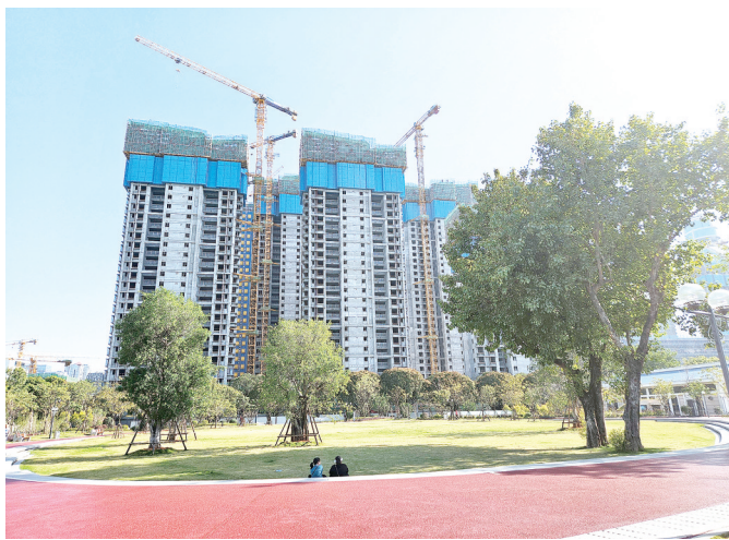
湖滨片区安置房住宅项目已全部封顶。记者 俞杰摄
