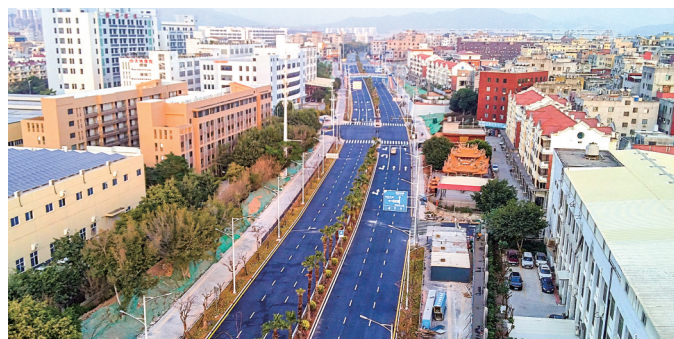
舩山东二路(春雷路—翔安东路)顺利通车。
