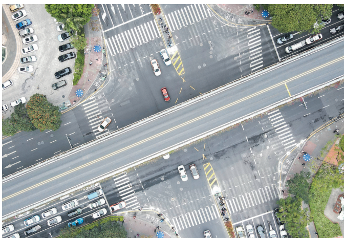
白鹭洲路厦禾路路口提升改造完成。
