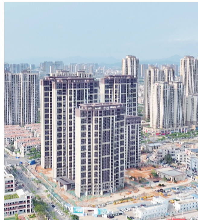
翔安欧厝新村“四统房”一期项目土建工程已完工。
