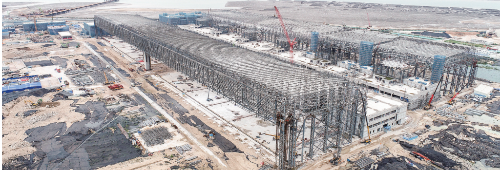
厦门太古翔安新机场维修基地项目规模宏大。
