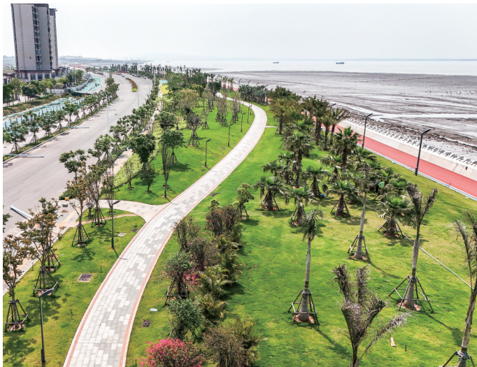
大嶝岛西侧护岸及环嶝路工程通过预验收。
