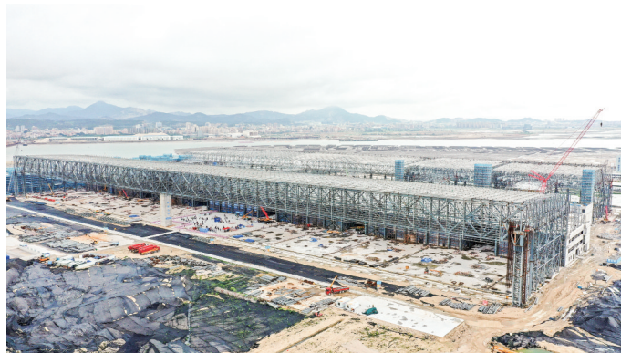
厦门太古翔安机场维修基地1号机库项目正在进行机电安装、屋面系统施工、装饰架拼装。记者 陈理杰 摄
