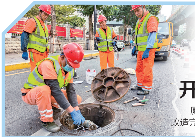
工作人员在对井盖进行“静音”改造。
