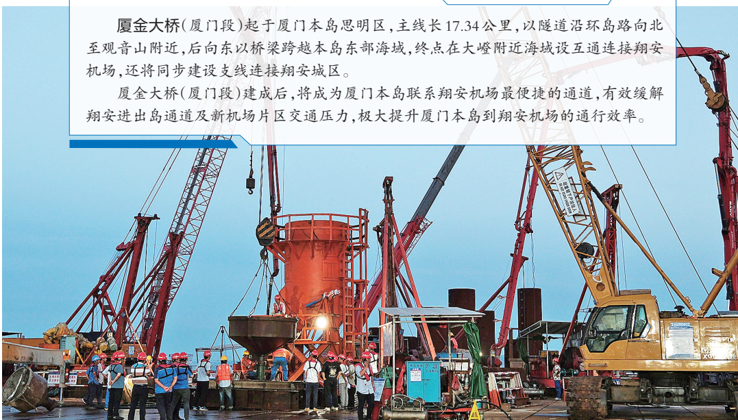
厦金大桥(厦门段)刘五店航道桥首根桩基浇筑成功。
