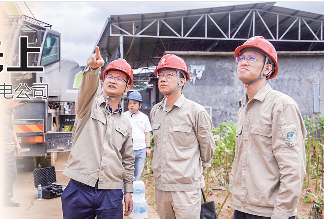
在龙岩上杭县白砂镇坝上村抢修现场,国网厦门供电公司安全总监童贞翔(中)与党员骨干蒋日坤(左)、雷显荣(右)在研究讨论10千伏白塘线新杆变组立及导线架设方案。
