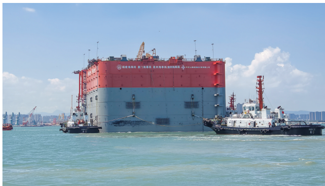
此次拖运的钢沉井面积相当于8个篮球场。记者 陈理杰 摄 福建省重点工程,是国家公路网规划中高速公路联络线的重要组成部分。项目建成后,将成为厦门本岛联系翔安机场最便捷的通道,有效缓解翔安进出岛通道及新机场片区交通压力。
