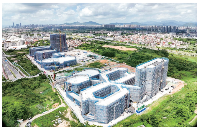
火炬高新实验学校主体结构顺利通过验收。
