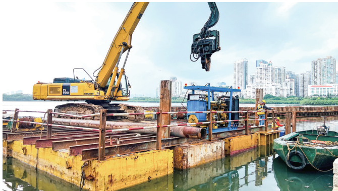
筓筓湖上,工人们正开展钢浮箱施工。记者 仇慧亮 摄
