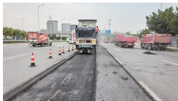
施工车辆正在铣刨路面。
