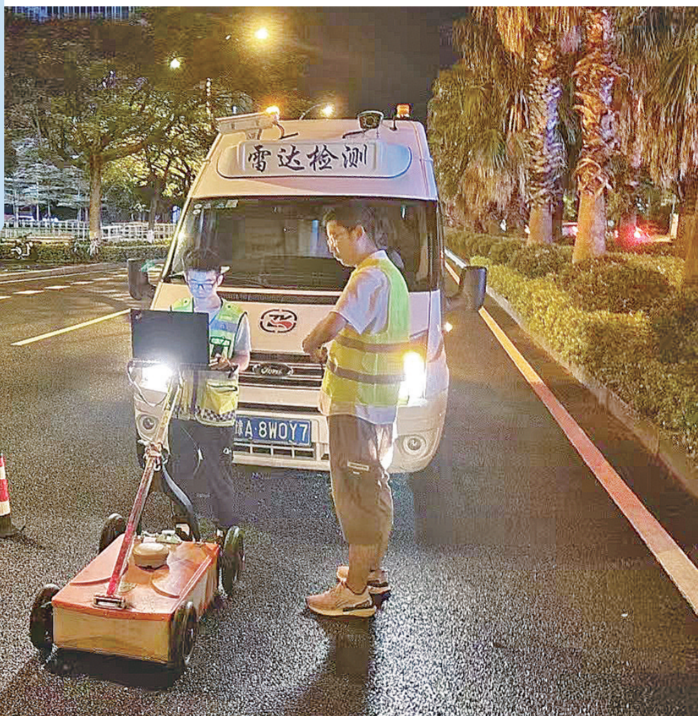
工作人员使用专业设备探测道路地下有无空洞等隐患。
