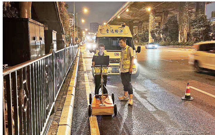
工作人员使用专业化设备对道路空洞进行探测。
