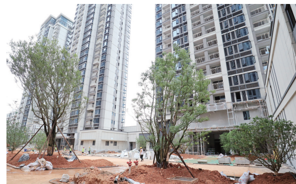
安商房外立面施工基本完成。 记者 俞杰 摄
