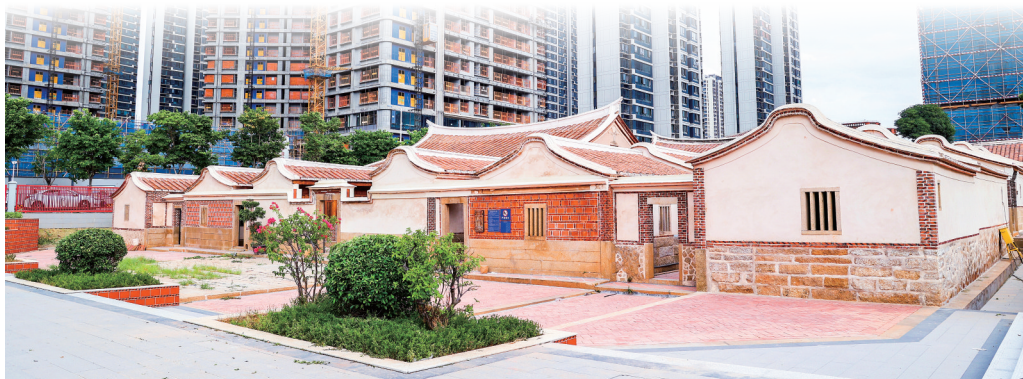
“坂美九十九间”修缮工作已完成,即将对外开放。记者 叶嘉健 摄
