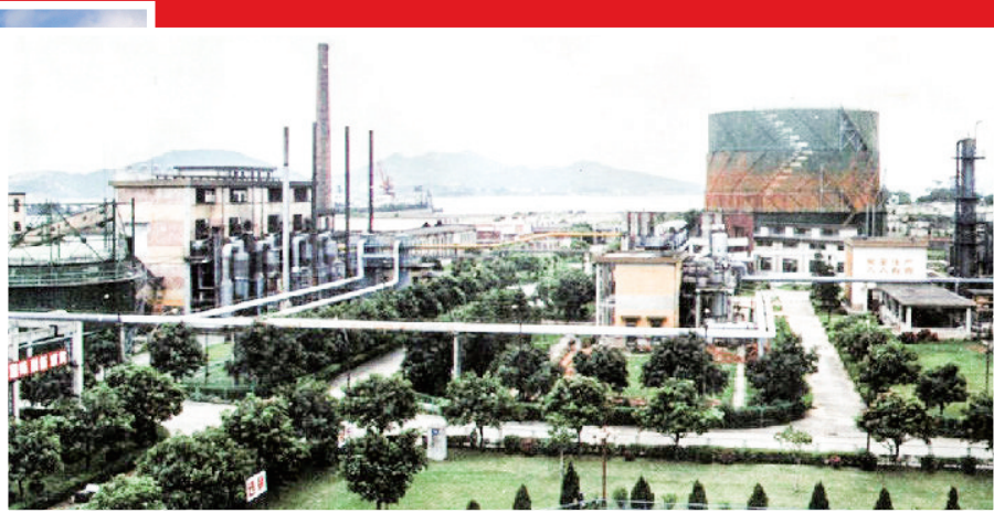
▲1990年,石湖山煤制气厂建成,厦门迈出管道燃气建设发展第一步。
