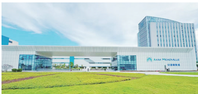
安捷利美维高端封装基板及高端HDI生产能力建设项目。
