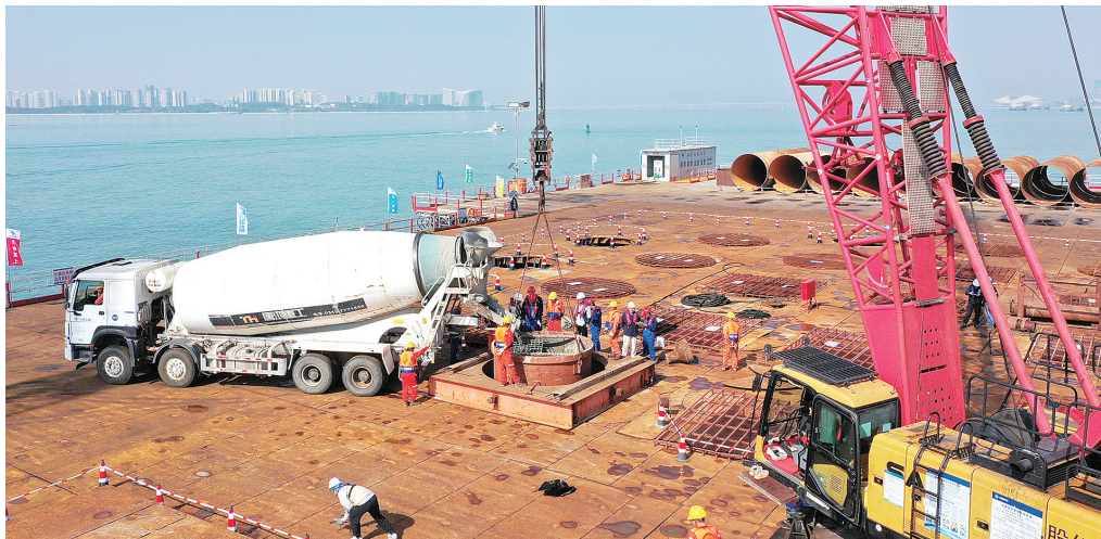
刘五店航道桥(悬索桥)东主塔桩基施工全部完成。记者 陈理杰 摄
