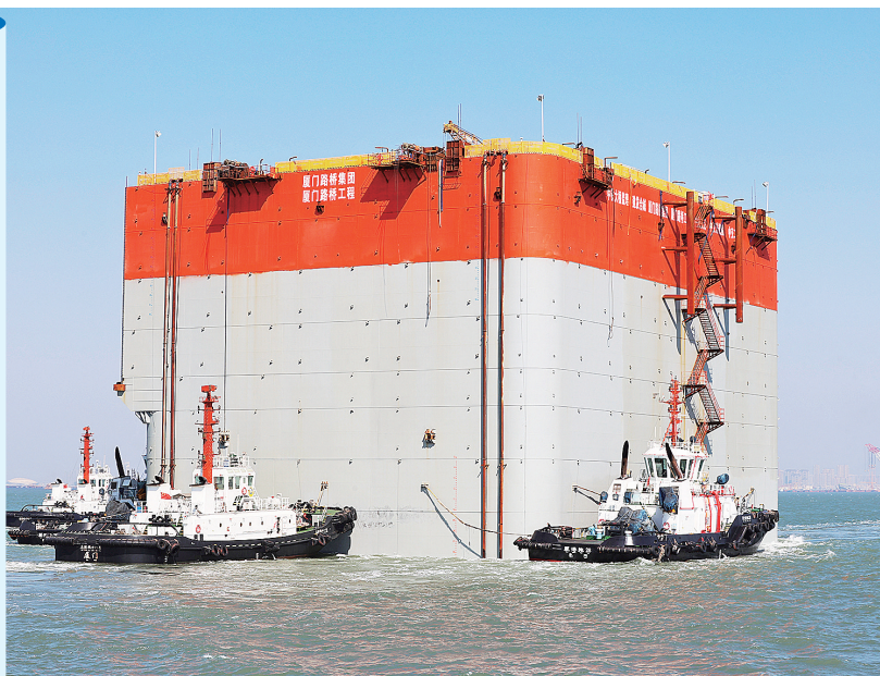
刘五店航道桥锚碇最后一个钢沉井顺利浮运到位。记者 唐光峰 摄
