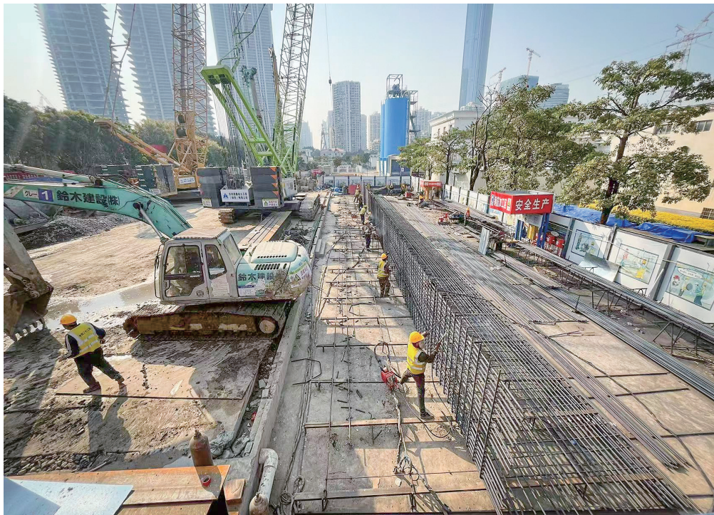
筲箕湖南岸排水排涝系统工程施工现场一片繁忙景象。记者仇慧亮摄
