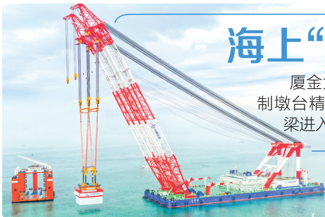
厦金大桥(厦门段)首个3000吨预制墩台精准吊装。记者 陈理杰 摄
