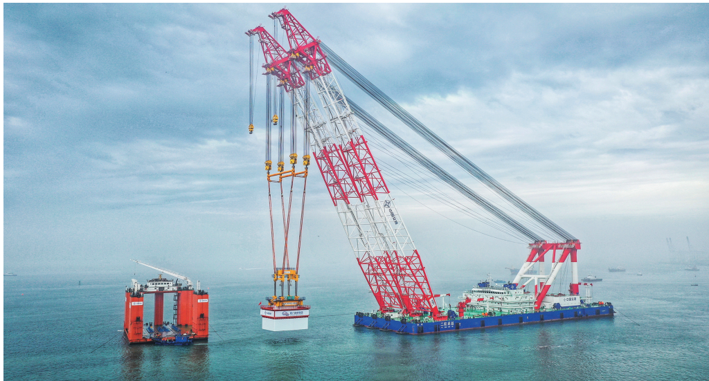
厦金大桥(厦门段)首件3000吨预制墩台精准吊装。记者 陈理杰 摄
