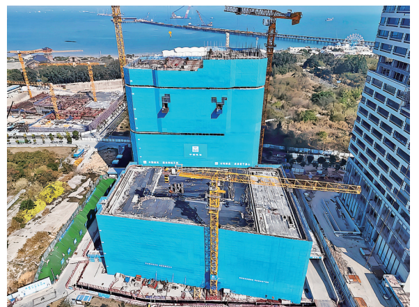
厦门农商银行总部大厦裙楼主体结构封顶。
