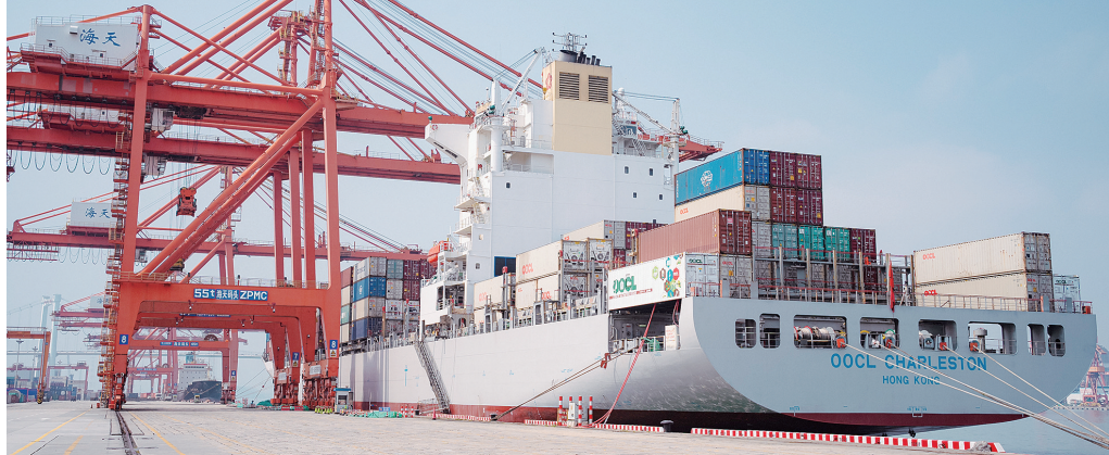
海天码头启用三套多制式岸电装置。
