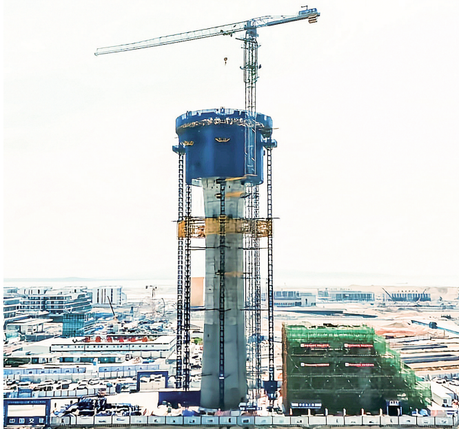
国内首台智能建造装备“造塔机”助力厦门新机场塔台工程建设。
