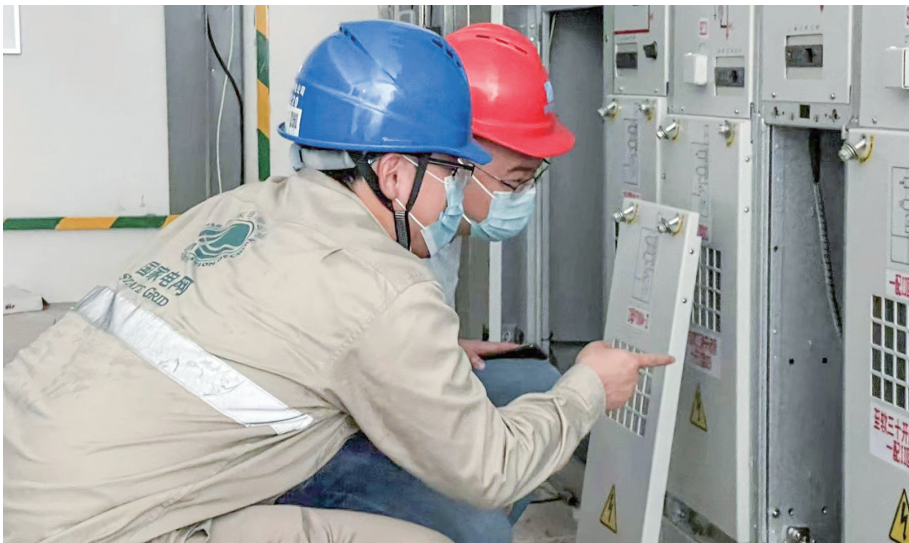
国网厦门供电公司电力人员正在进行送电前的调试、检验。 通讯员供图
