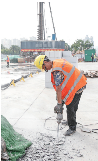
厦门电力与清水进岛隧道项目施工现场。 记者 陈理杰 摄
