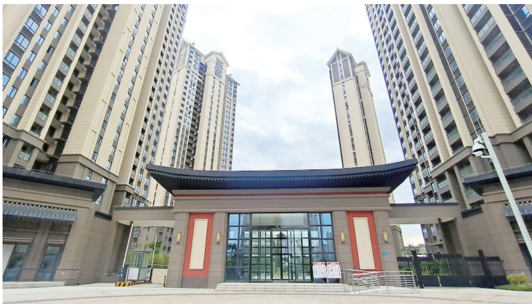
佳美安置房将成为马銮湾新城年内首个交付的安置房项目。
