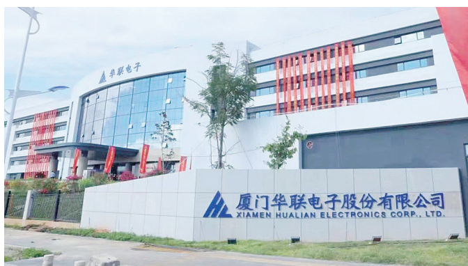
华联电子(翔安)工业园竣工。
