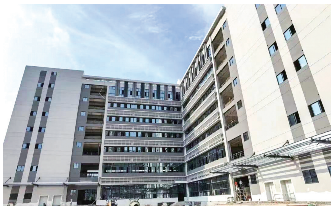
同翔通用厂房二期已顺利完工。
