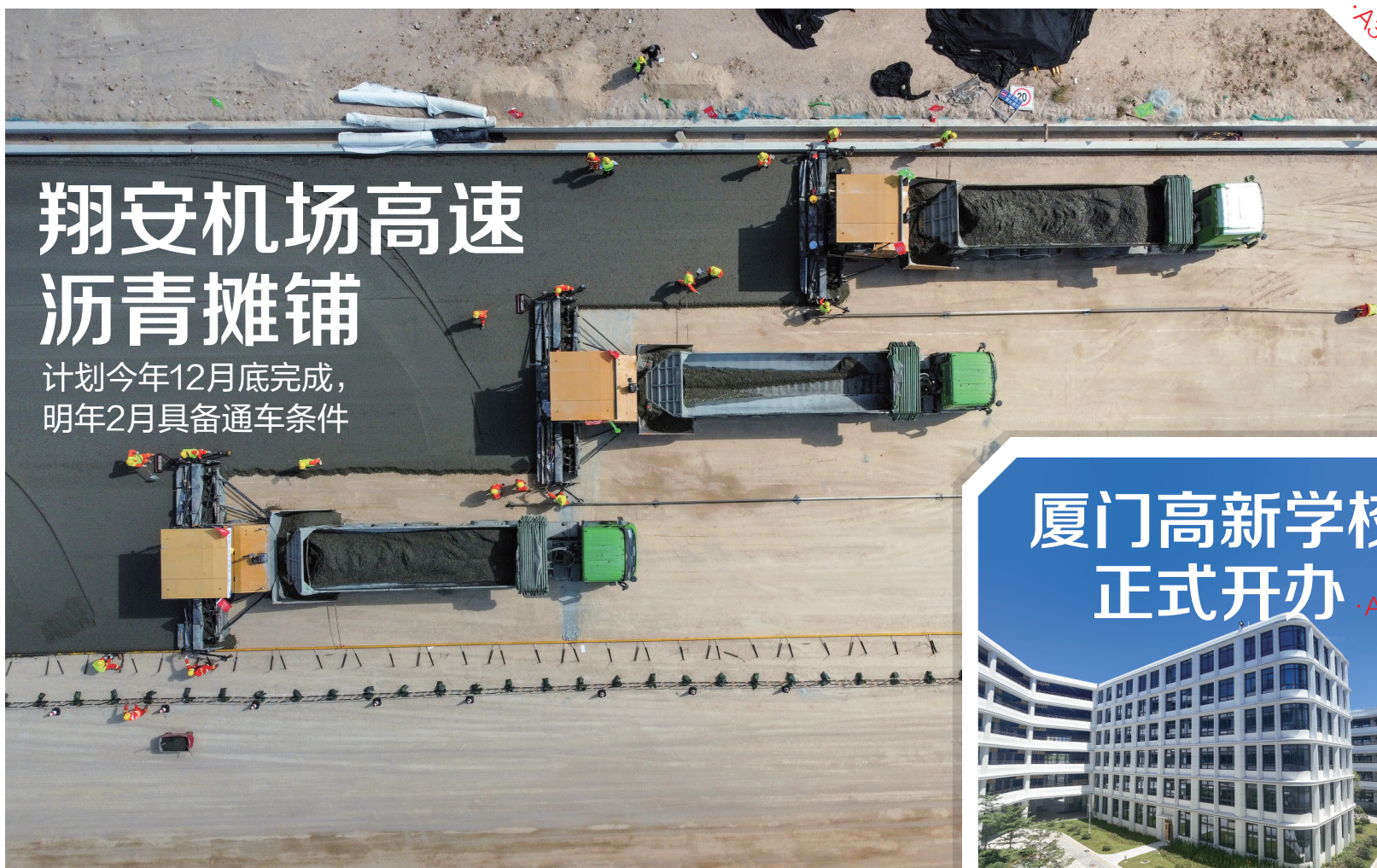
翔安机场高速启动路面沥青摊铺。
