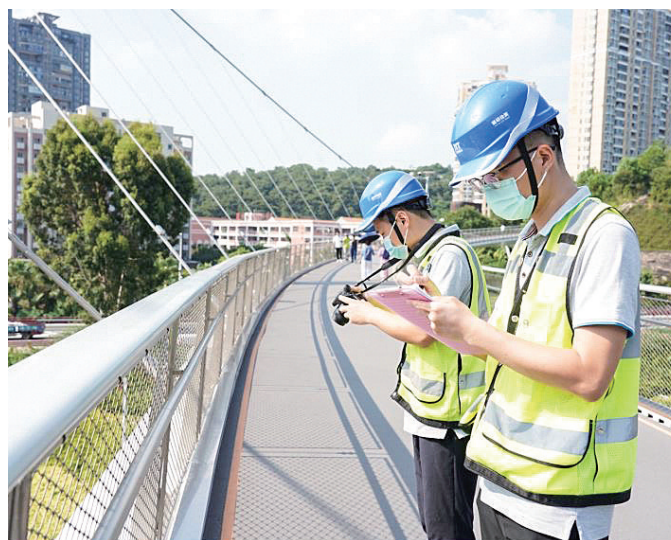
对步道外观进行检测。记者 王世伟 摄
