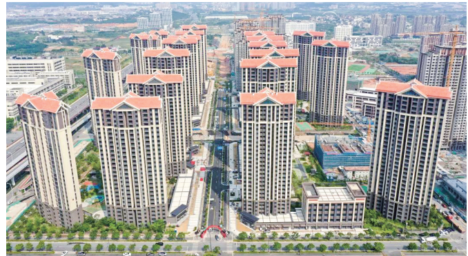
佳美安置房项目位于马銮湾新城西片区。
