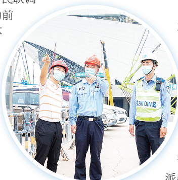
民警对工地的安全工作落实情况实地检查。
