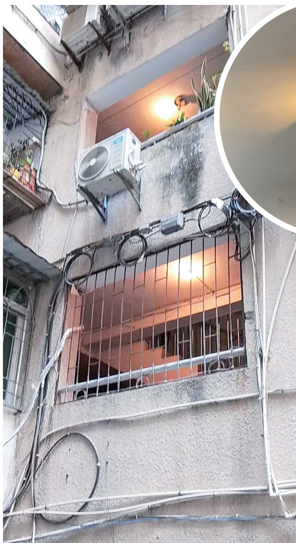
楼道灯修好后,居民再也不用担心摸黑走楼梯了。
