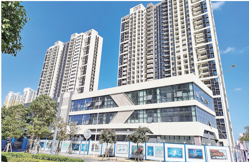
五通金浦花园安置房项目正在进行室内外装修施工。
