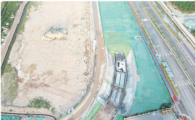
北溪引水主干渠改造工程(马銮湾新城段)施工现场。
