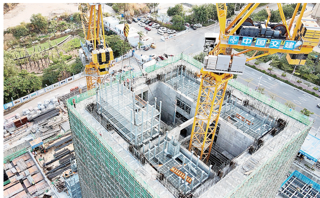
集美新城核心区在建的厦门白鹭西塔项目将用上“空中造楼机”。
