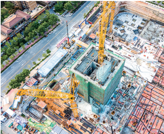
厦门白鹭西塔项目“空中造楼机”6个内筒架安装完成。孙二伟 摄
