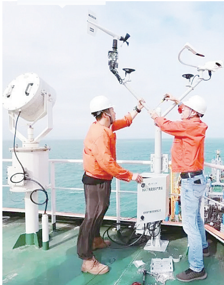
工作人员在船上安装海上5G专网船舶自动气象站。
