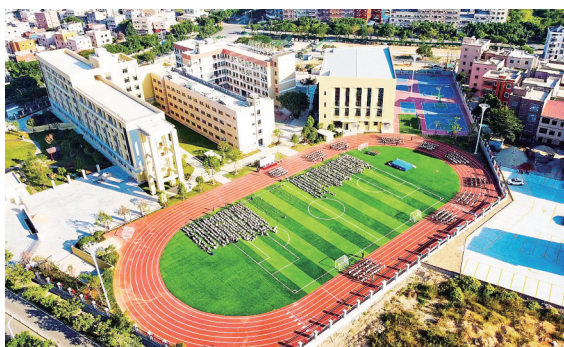
厦门市翔安区逸夫小学扩建项目完成竣工验收。
