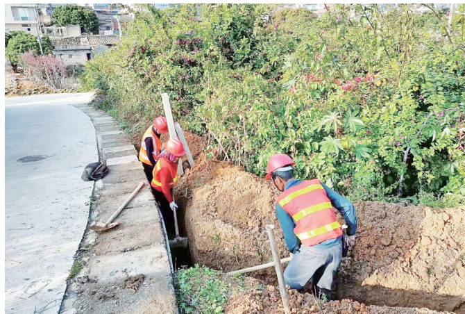
翔安市政工人开挖管道沟槽,助力农村生活污水治理。
