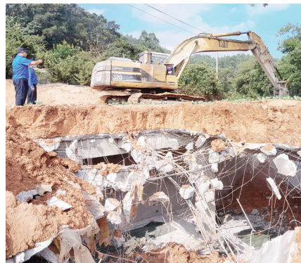
△莲花中队及时组织拆除工人将违建拆除。蔡剑明 摄
