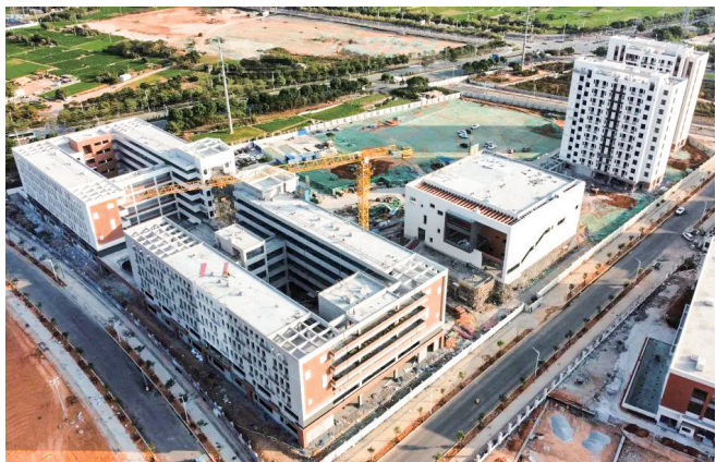
环东海域新城浦园高中正在加快建设。
