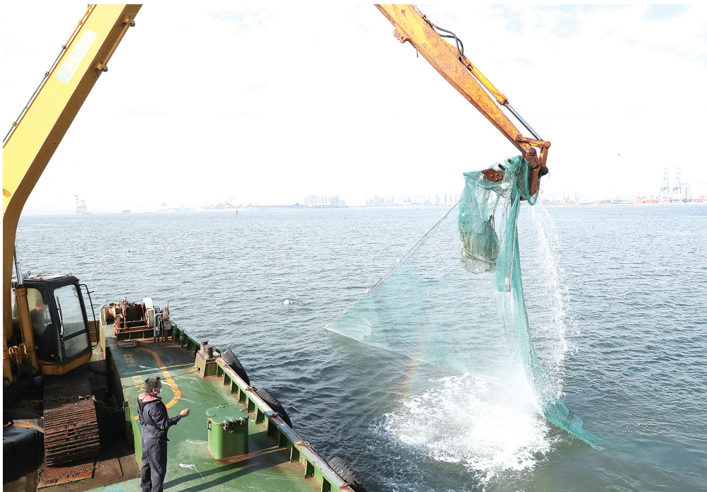
钩机船正在进行清障工作。
