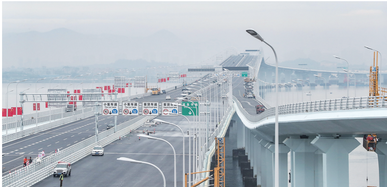
翔安大桥跨海段按照双向八车道设计,翔安段高架桥标准段为双向六车道。 记者 唐光峰 摄
